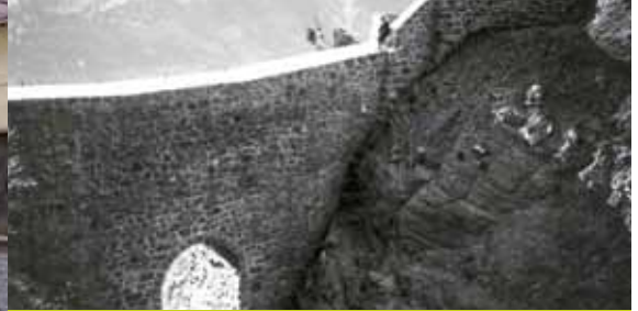
Dique vacío para la defensa y control de los aludes en el barranco de Epifanio
